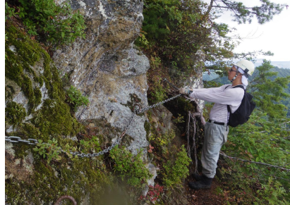
岸壁にチェーン張り
